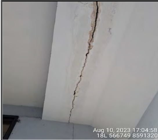
Instituto Superior Tecnológico Churcampa. Se visualiza rajaduras en el techo, por el cual filtra humedad.
