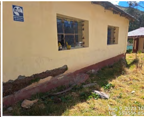
Inicial - Jardín 1105- Seclla (Angaraes). Se visualiza rajaduras y humedad en el techo y pared de la institución
