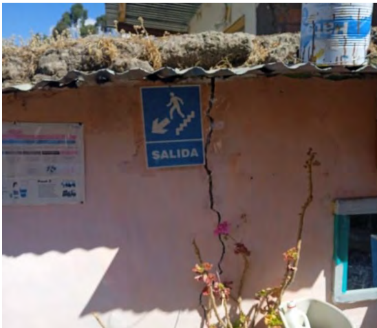
Inicial 672 Yauli (Huancavelica). Se visualiza rajaduras al exterior de la institución
