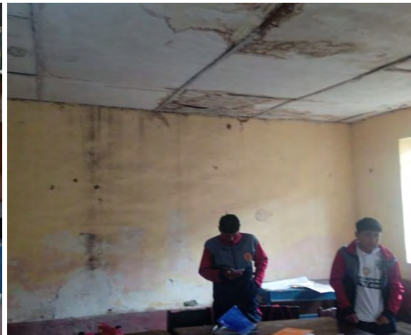
Inicial 672 Yauli (Huancavelica). Se visualiza rajaduras y humedad en el techo y pared de la institución
