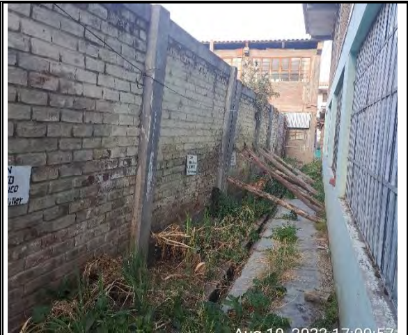
Instituto Superior Tecnológico Churcampa. Las paredes están sostenidas por palos, ya que están a punto de colapsar.
