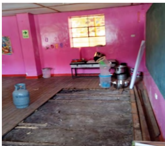
Inicial - Jardín 560 - Anchonga (Angaraes). Se visualiza piso en muy mal estado y paredes húmedas
