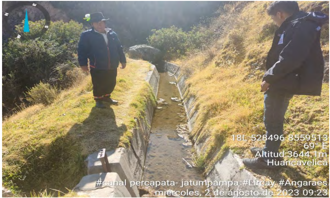
FOTO 05. Se evidencia al personal responsable de diagnóstico situacional en línea de conducción canal abierto de material concreto de las coordenadas geográficas este 528496 y oeste 8559513, donde se puede evidenciar lateras de la línea de conducción se encuentra inoperativos de agua por fisura o rajadura de las compuertas en todas partes de zonas críticas.
