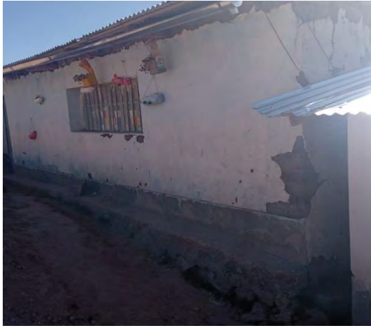
Inicial 36818-Paucara (Acobamba). Exterior de la aulas en muy mal estado pared rajadas y veredas rajadas
