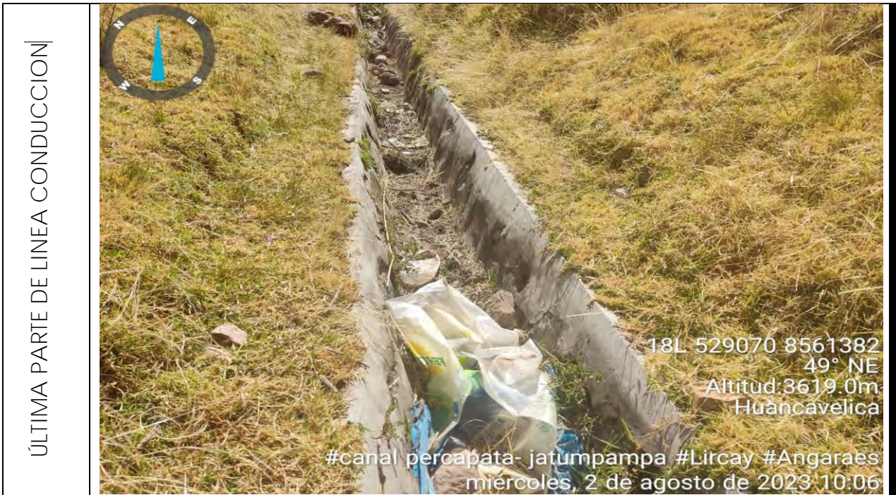
FOTO 07. Se evidencia al personal responsable de diagnóstico situacional en línea de conducción canal abierto de infraestructura concreto de las coordenadas geográficas este 529070 y oeste 8561382. donde se puede evidenciar fisura o rajadura del canal abierto y presencia de malezas y no hay presencia de agua por filtración en zonas críticas en la línea de conducción por ello no hay presencia de agua, de una longitud de 500 metros
